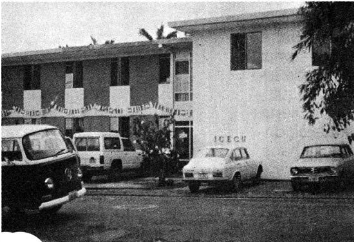
En este edificio, en Costa Rica, están las oficinas de Escuela para Todos.
